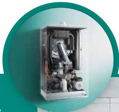
Vaillant infatti mette a disposizione una gamma di prodotti indicati per la fumisteria oltre a molteplici opzioni per quanto riguarda l'accessoristica dedicata alla caldaia: un pressostato fumi, unito all'elettronica, autoregola il valore da impostare per la lunghezza dell'intubamento verticale così da evacuare correttamente i fumi esausti.
